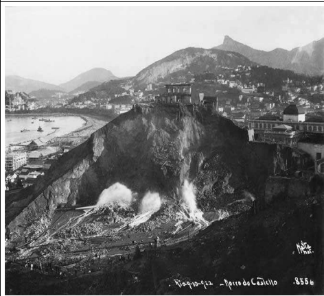
Fig. 2. Desmonte do Morro do Castelo, RJ. Foto de Augusto Malta, 1922.
