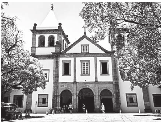
Mosteiro de São Bento (RJ)
